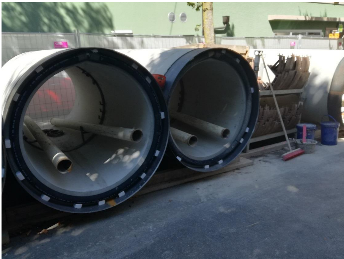
Fertig installierte Hydraulische Fuge auf der Baustelle
