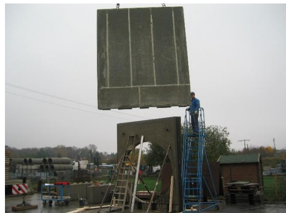
Montage der ersten und zweiten Platte
