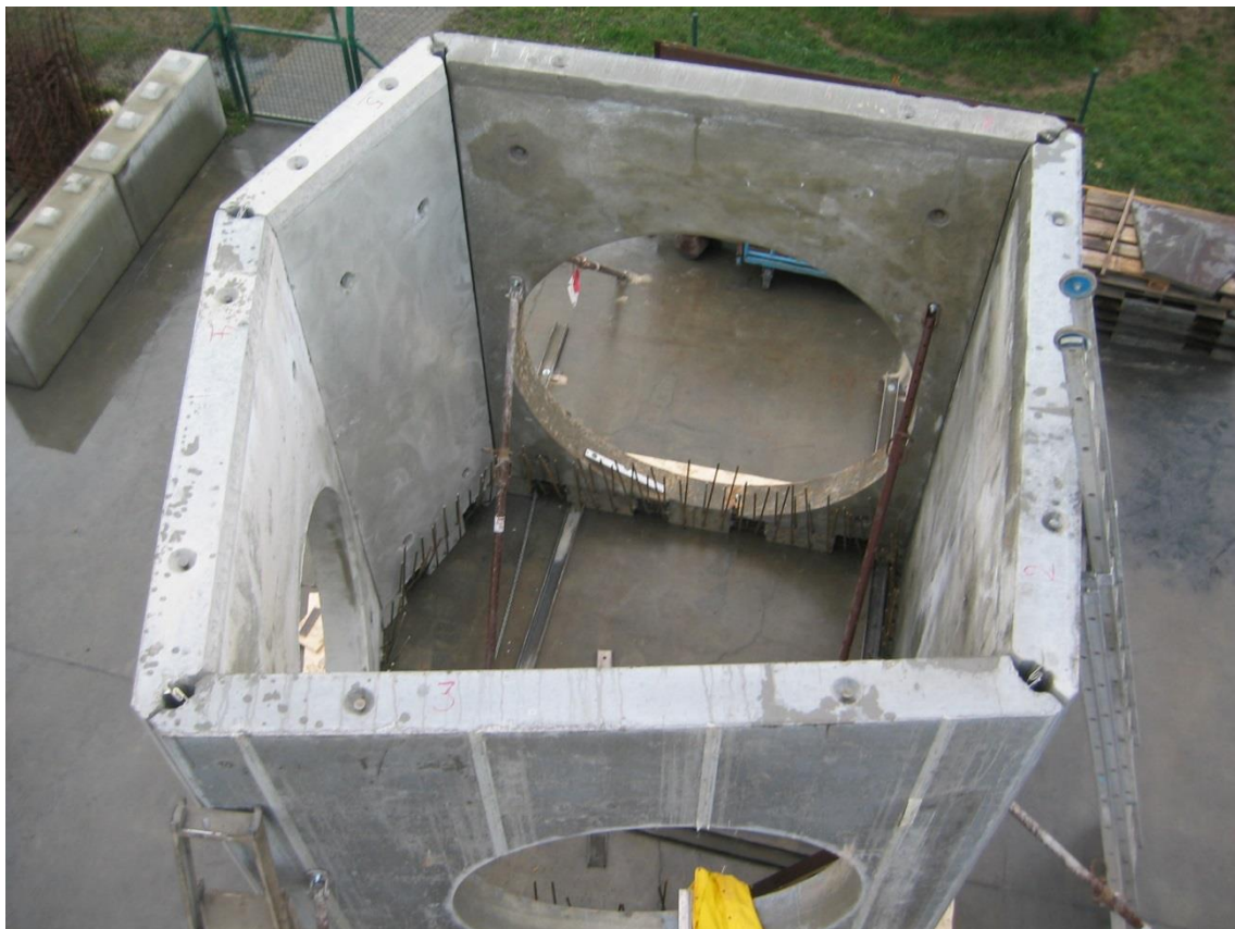
Fertig aufgestelltes Bauwerk
