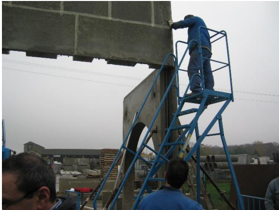
Einfädeln der zweiten Wandplatte
