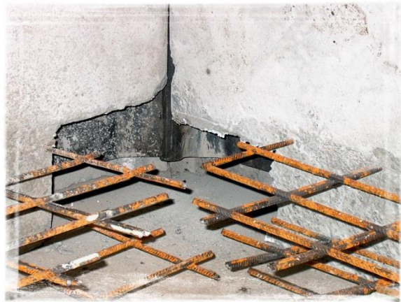
Eckverbindung Wand/Wand/Boden
