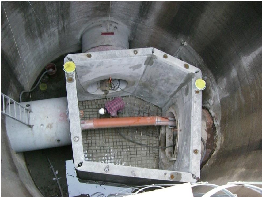
Bauwerk kurz vor dem betonieren der Sohle
