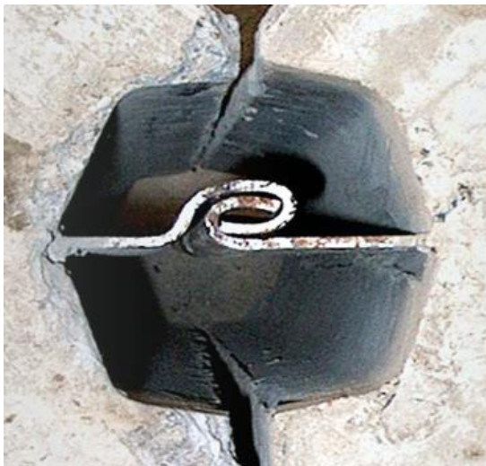
Vertikales Fugenblech
