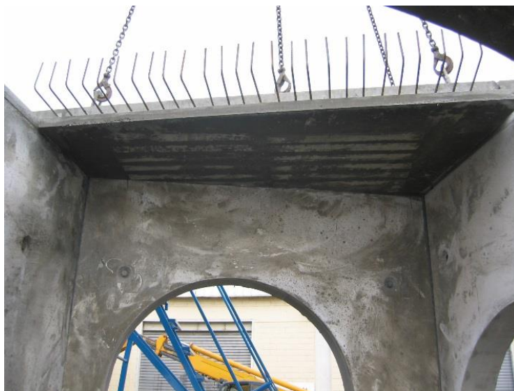
Auflegen einer geteilten Abdeckplatte
