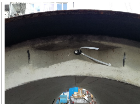
Montierte Gummilasche mit Kabelbinder
