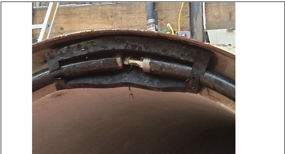
Montierter Dichtschlauch mit Dichttasche und Regulierungsanschluss
